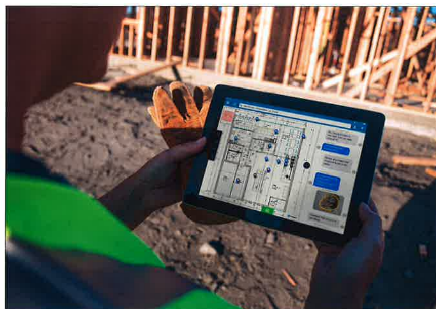
Direkte und ortsunabhängige Kommunikation mit allen Projektbeteiligten.
